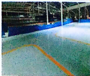
Epoxy & PU Flooring
